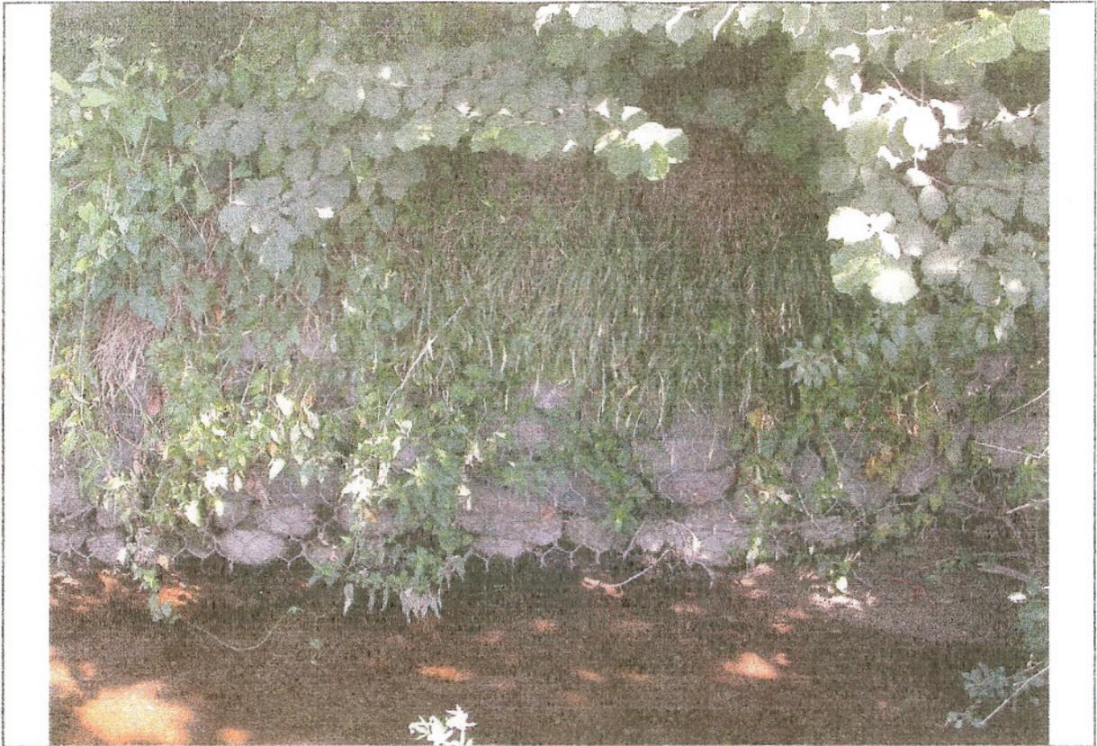
**Foto n.22** – Dettaglio gabbioni sostegno sede viaria in sponda destra lungo la via Per Molteno
