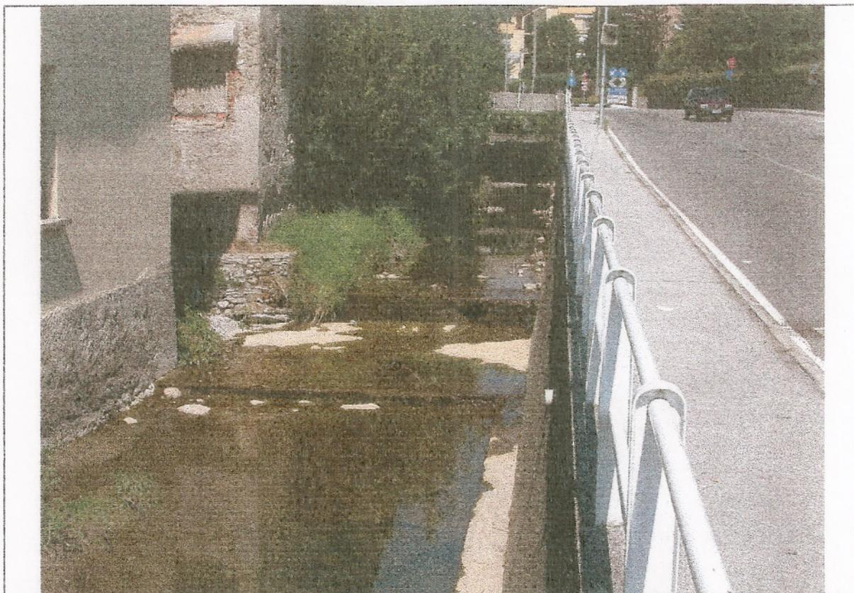
Foto n.8 – Alveo incanalato artificialmente con salti di fondo nell'abitato di Dolzago
